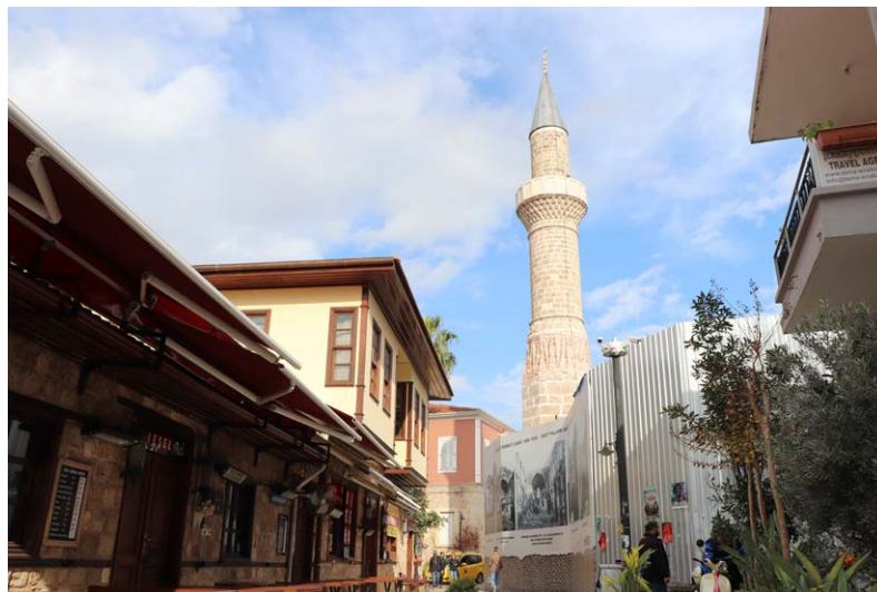
図 14 修復が完了した尖塔（2019年12月撮影）
