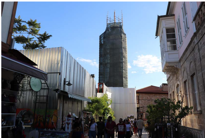
図 13 修復中の「折れた」尖塔（2019年5月撮影）
