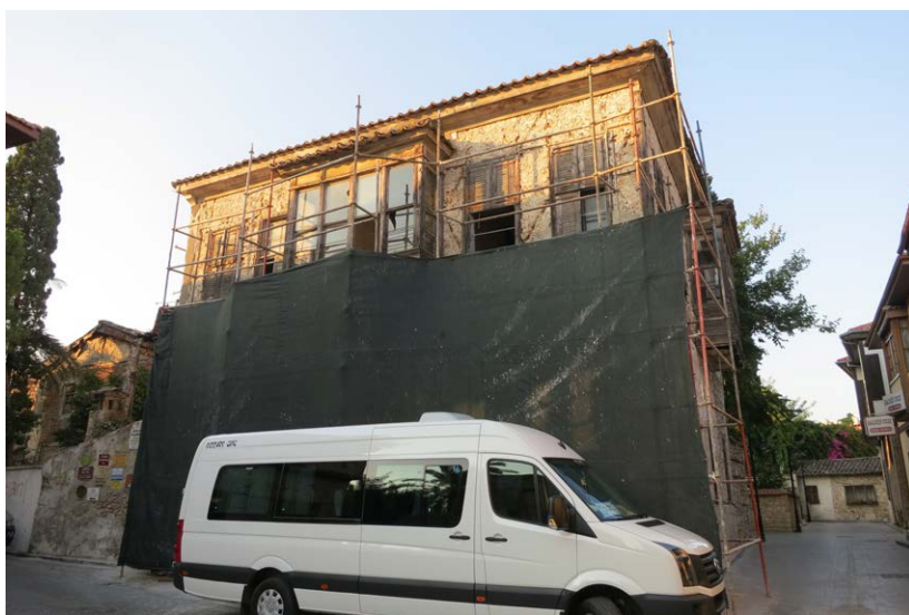
図8 修復が進められていた伝統家屋（2012年8月撮影）
