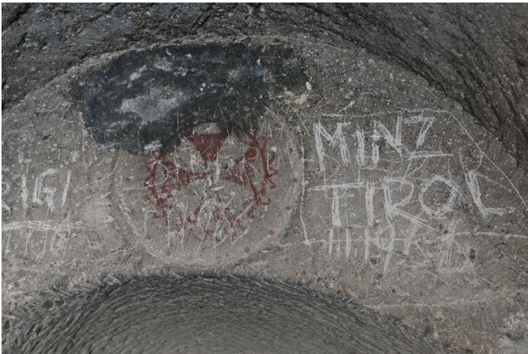
図2 現代の落書きによる損傷のある教会（聖シメオン）
