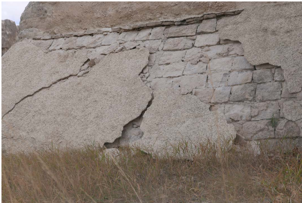
図3 脆弱な凝灰岩製の教会躯体の損傷（エル・ナザレ教会）
