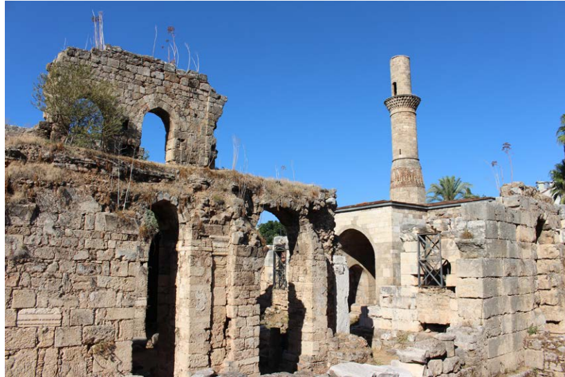
図 11 再建工事に入る直前のケシッキ・ミナーレ（2017 年 8 月撮影）
