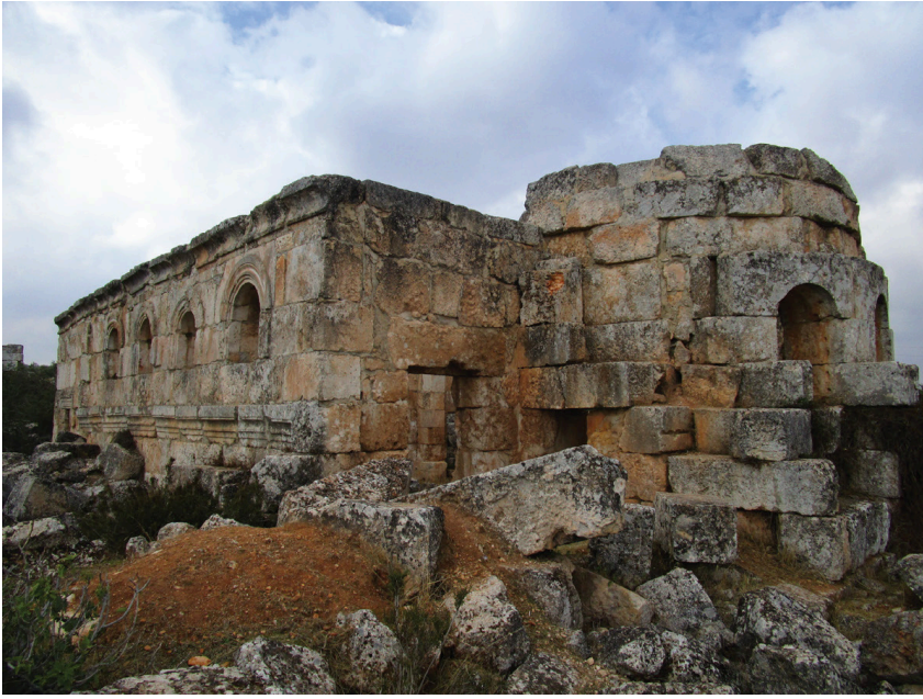
منظر عام من الجنوب الشرقي يظهر الحنية والواجهة الجنوبية
