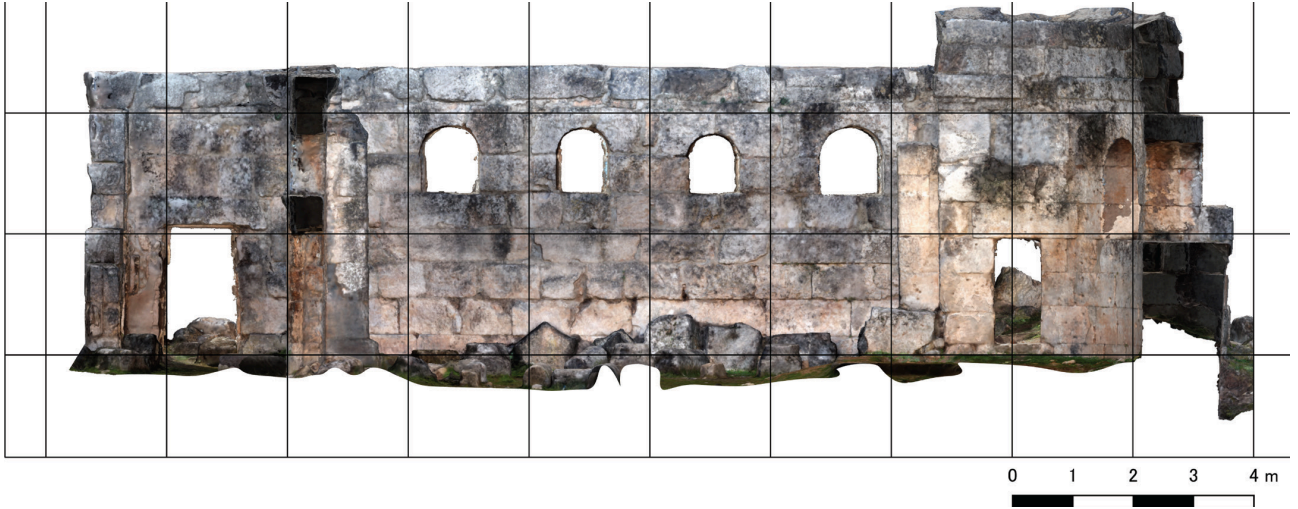
الشكل ١٤: مقطع من الجدار الداخلي (الجدار الجنوبي)
