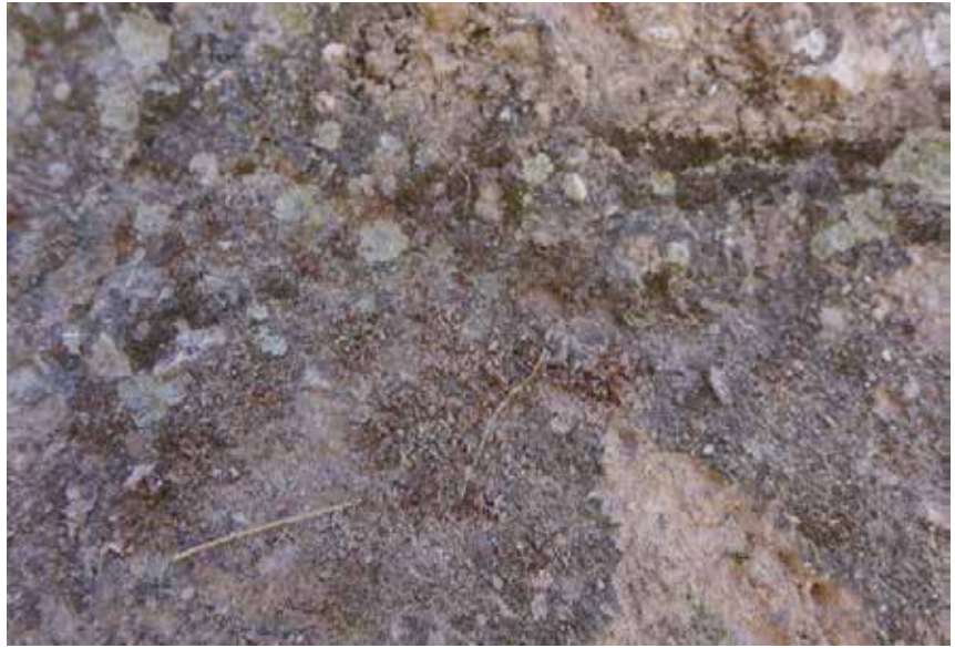
図5: 教会外壁北側の付着生物
