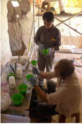
Figure 3.10 On-site mortar preparation Şekil 3.10 Yerinde harç hazırlığı
