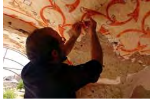
Figure 3.13 Grouting work at the narthex Şekil 3.13 Nartekste yapılan enjeksiyon çalışması
