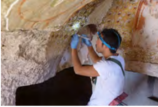
Figure 3.12 Grouting work at the altar Şekil 3.12 Mihrap'ta yapılan enjeksiyon çalışması
