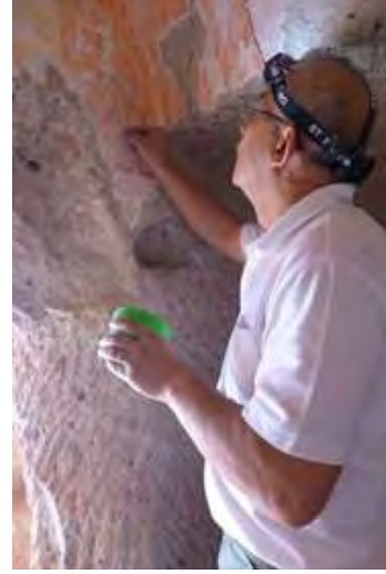
Figure 3.11 Edging work at the nave Şekil 3.11 Kilise ortasındaki dolgu harç çalışması
