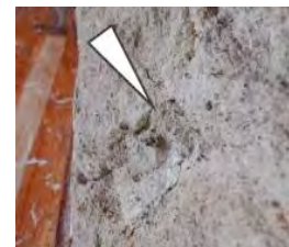
d. Spalling
